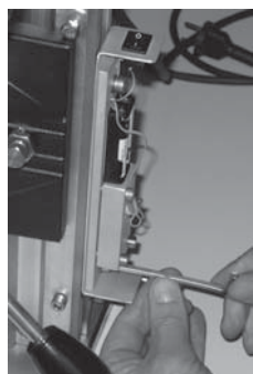
Instalación del láser
