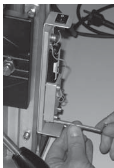
Installation du laser
